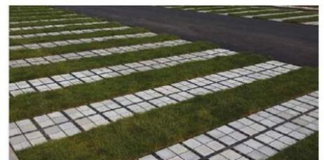
Le système breveté des modules ECORASTER BLD24 est résistant aux charges lourdes, aux UV et aux sécheresses. Ces modules s'adaptent aux différentes configurations. Ils laissent passer l'air et permettent d'obtenir un coefficient de ruissellement nul. Dans ces systèmes alvéolaires, on pose les pavés de remplissage. Il sont disponibles en quatre couleurs et ne nécessitent aucun entretien particulier. Ils permettent un calage précis.
