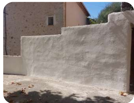
Préparation du mur de la cour élémentaire pour une fresque murale
